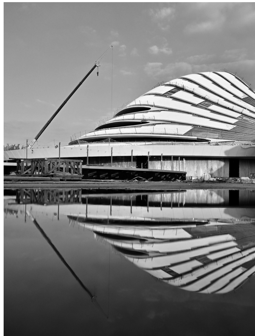
建设中的南湖未来广场
