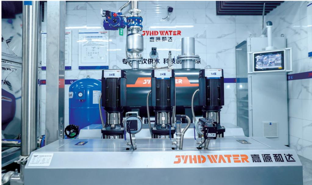
的实际运行效率;一体式供水设备采用一体式模块化设计,占地面积少,无需新建泵房,可直接放置于户外环境;预制泵站建设周期短,占地面积少,自动化程度高,能够有效解决传统泵池淤积、淤泥堆积或结块、不能自动清理、维护成本高等问题。
