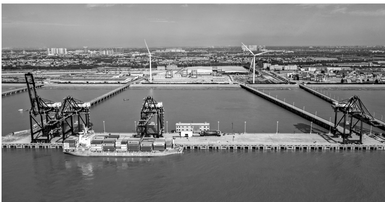
昨天，嘉兴港独山港区B25、B26泊位和Ⅱ号内河港池开港仪式成功举行。该工程是乍浦港区外的又一个集装箱海河联运新作业区，是被列入省“千项万亿”项目的重大项目，将为加快长三角海河联运枢纽港建设，助力世界一流强港建设增添新动力。
