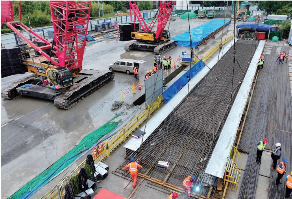
昨天下午,嘉兴至枫南铁路嘉兴科技城站首幅地连墙顺利开槽,标志着该站正式进入主体结构施工阶段。(详情见2版)
