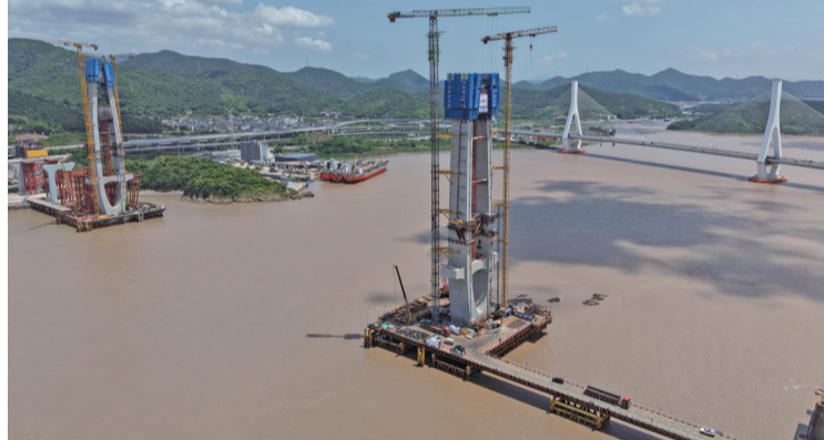
5月17日拍摄的甬舟铁路富翅门公铁两用大桥西主塔上横梁浇筑现场(无人机照片)。5月17日，由中国铁建大桥局承建的甬舟铁路富翅门公铁两用大桥西主塔上横梁顺利浇筑完成。富翅门公铁两用大桥连接舟山本岛与富翅岛，是甬舟铁路的控制性工程之一。大桥全长约1726米，主跨达388米，采用双线铁路、6车道高速公路同层布置的形式。
