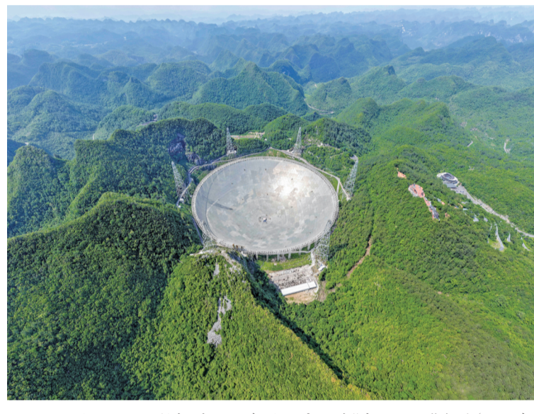
2026年5月7日拍摄的位于贵州平塘县的“中国天眼”全景(无人机照片,维护保养期间拍摄)。
