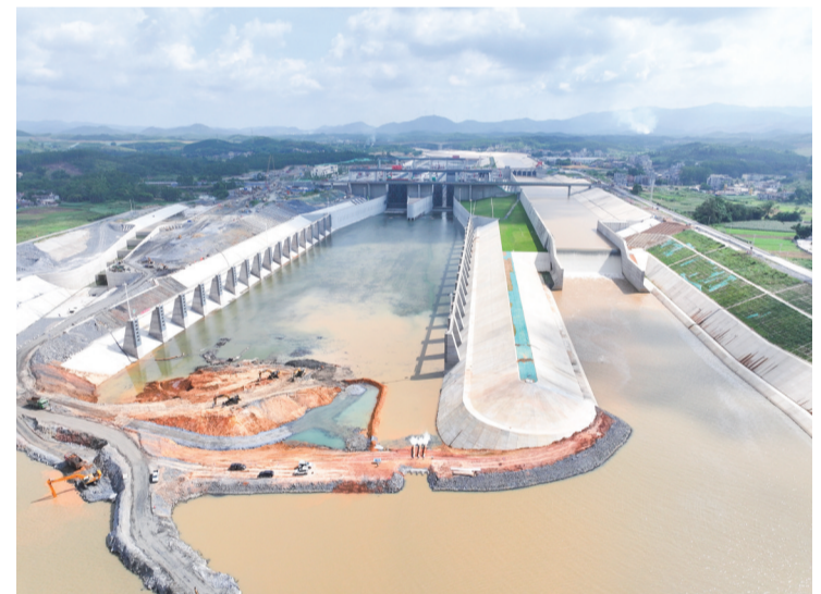
这是6月3日拍摄的广西平陆运河企石枢纽充水现场(无人机照片)。
