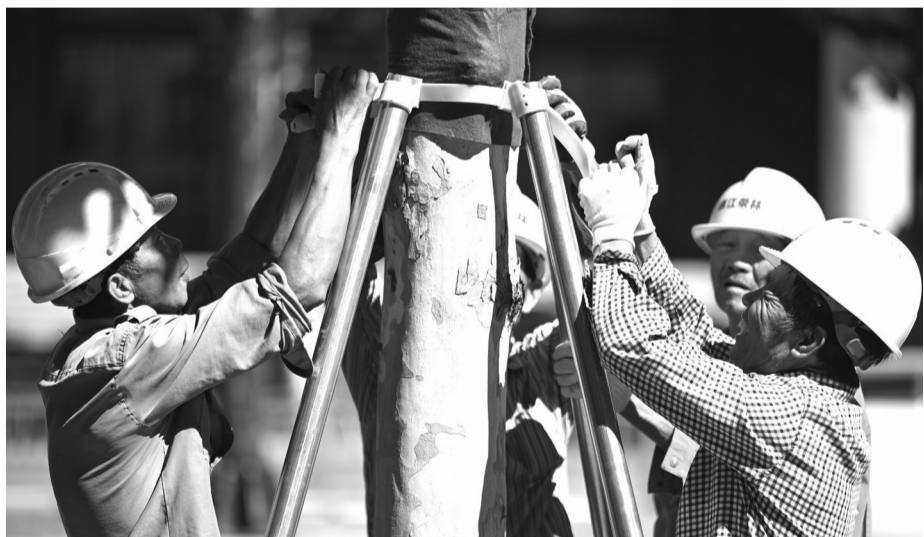
昨天,在市区城东路,工人师傅正抓紧对行道树开展加固作业。 ■摄影 记者 张启帆
