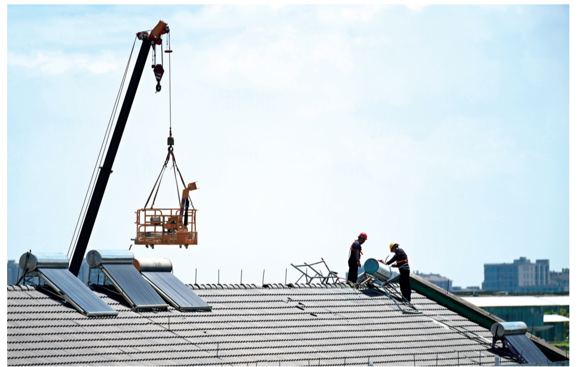
在市区南湖街道子城社区,工作人员正在拆除屋顶的老旧太阳能热水器集热管。
