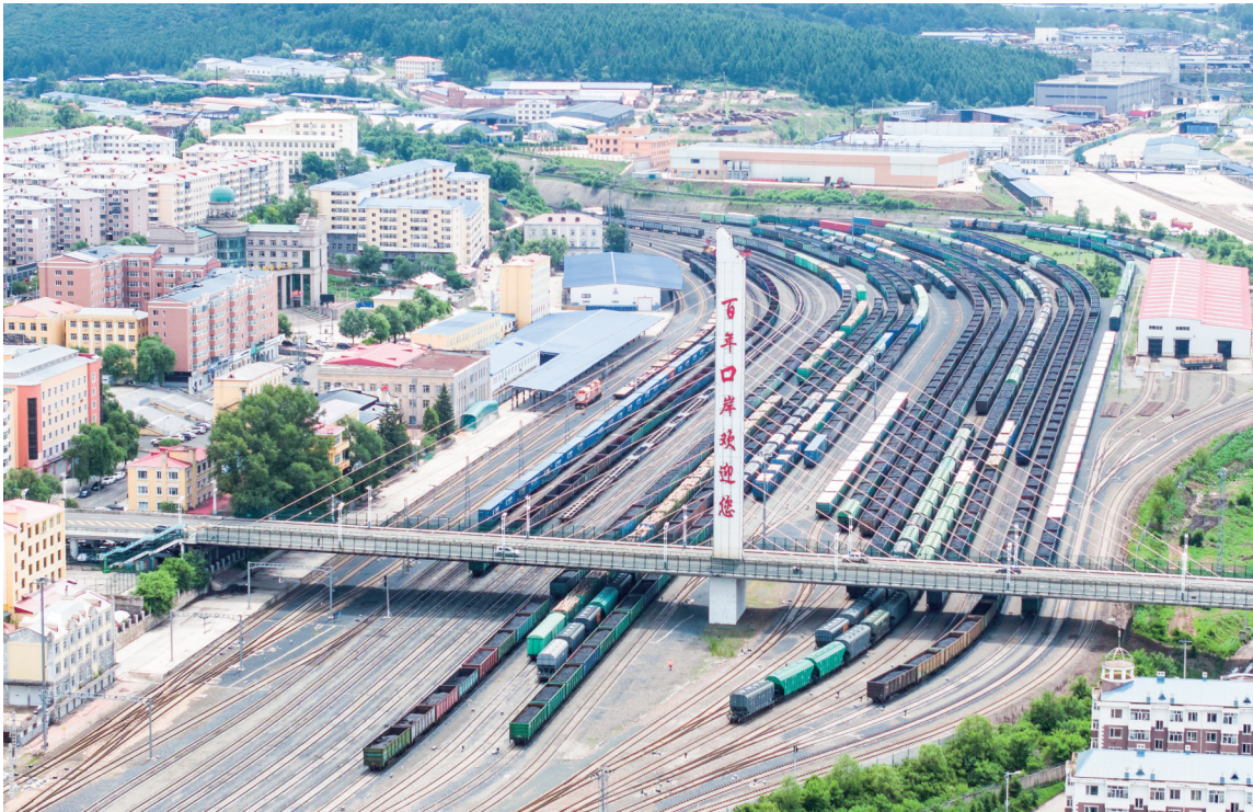
7月13日，回程中欧班列在绥芬河站南场等待换装（无人机照片）。
