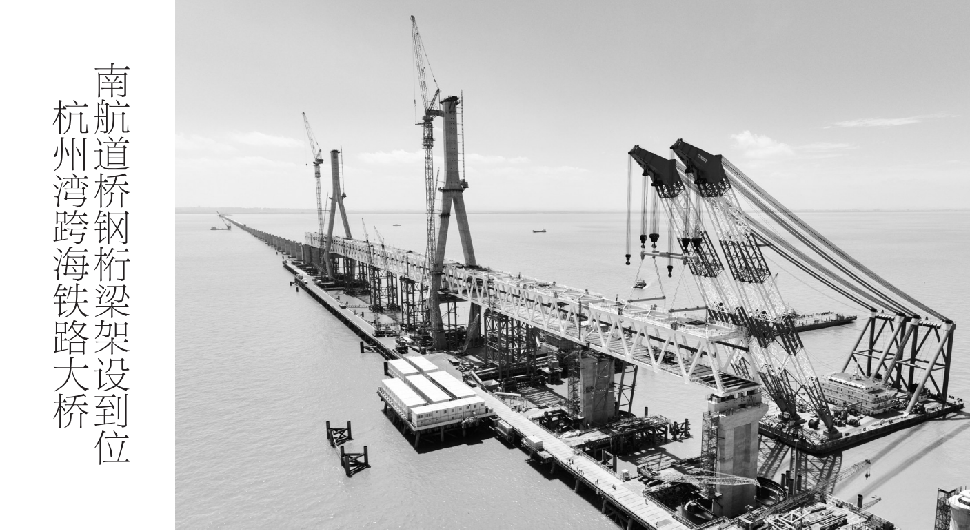
7月26日拍摄的杭州湾跨海铁路大桥南航道桥钢桁梁架设现场（无人机照片）。7月26日，由国铁上海建设公司建设管理、中交二航局承建的杭州湾跨海铁路大桥南航道桥钢桁梁全部架设到位，标志着这一工程建设取得阶段性进展。杭州湾跨海铁路大桥是新建南通至宁波高速铁路关键控制性工程，全长29.2公里，采用时速350公里双线无砟轨道设计，由北、中、南三座航道桥及海中引桥、浅滩区引桥共同组成。
