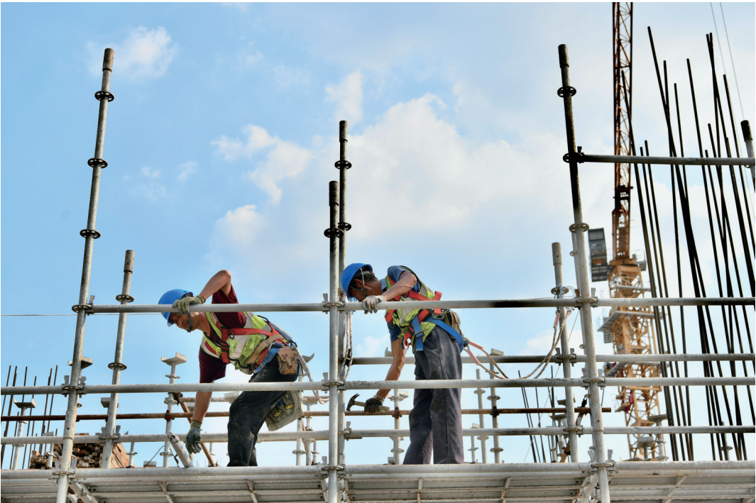
近日，嘉兴运河湾新城未来智造产业谷(一期)项目工地上塔吊林立、机械轰鸣，工人们正在一线加紧施工。该项目目前已全面进入地上主体结构施工阶段，预计今年10月竣工。针对近日持续高温，施工方适当调整了工作时间，同时为工人们提供解暑饮品，保障生产安全。
