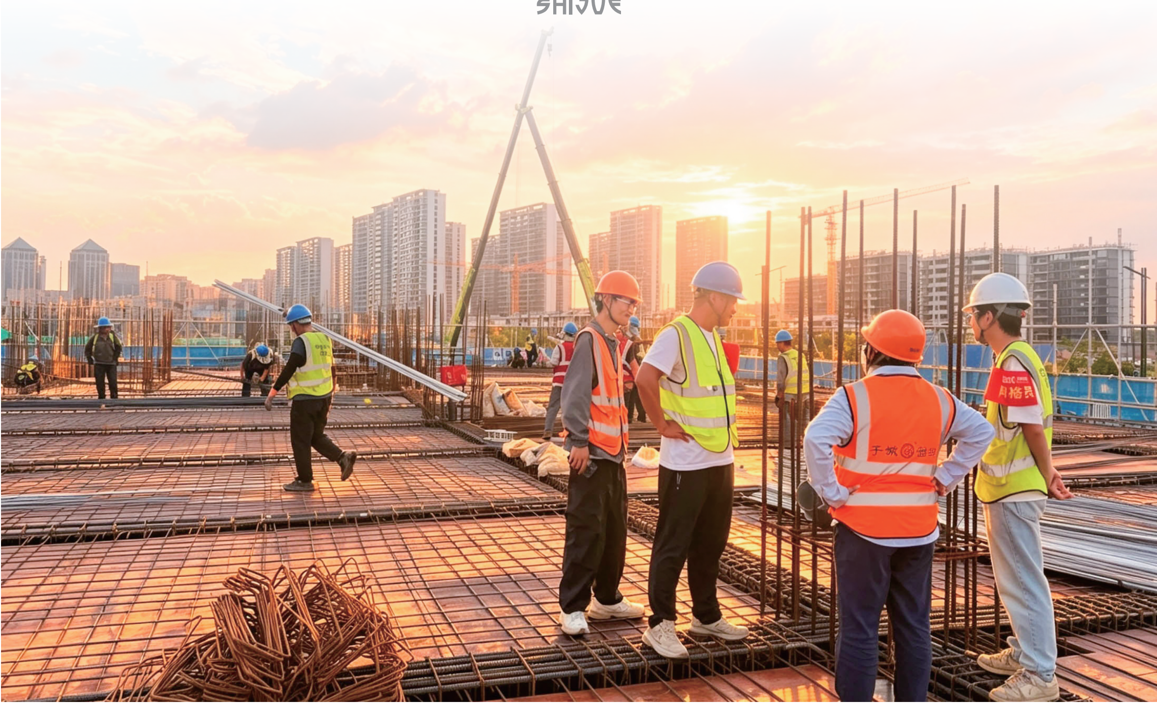
作品名称:《晚霞》 作者:金哲栋 简介:晚霞洒满作业楼面,管理人员现场踏勘协调,抢抓施工节点。
