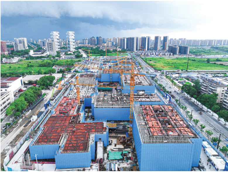
作品名称:《云端筑新城》 作者:梁爽 简介:航拍全景,多楼栋同步施工,项目建设如火如荼。
