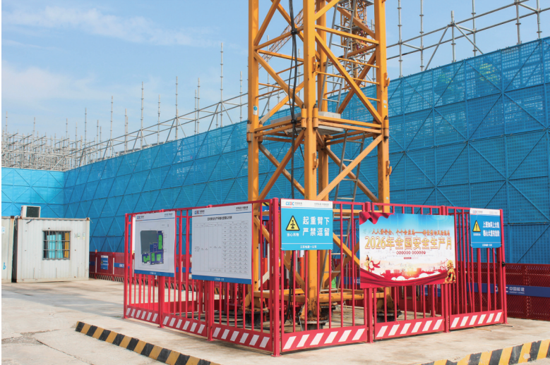
作品名称:《塔吊下的安全防线》 作者:范思慧 简介:塔吊区域设置标准化防护围挡,安全警示标识齐全,压实现场安全管理。
