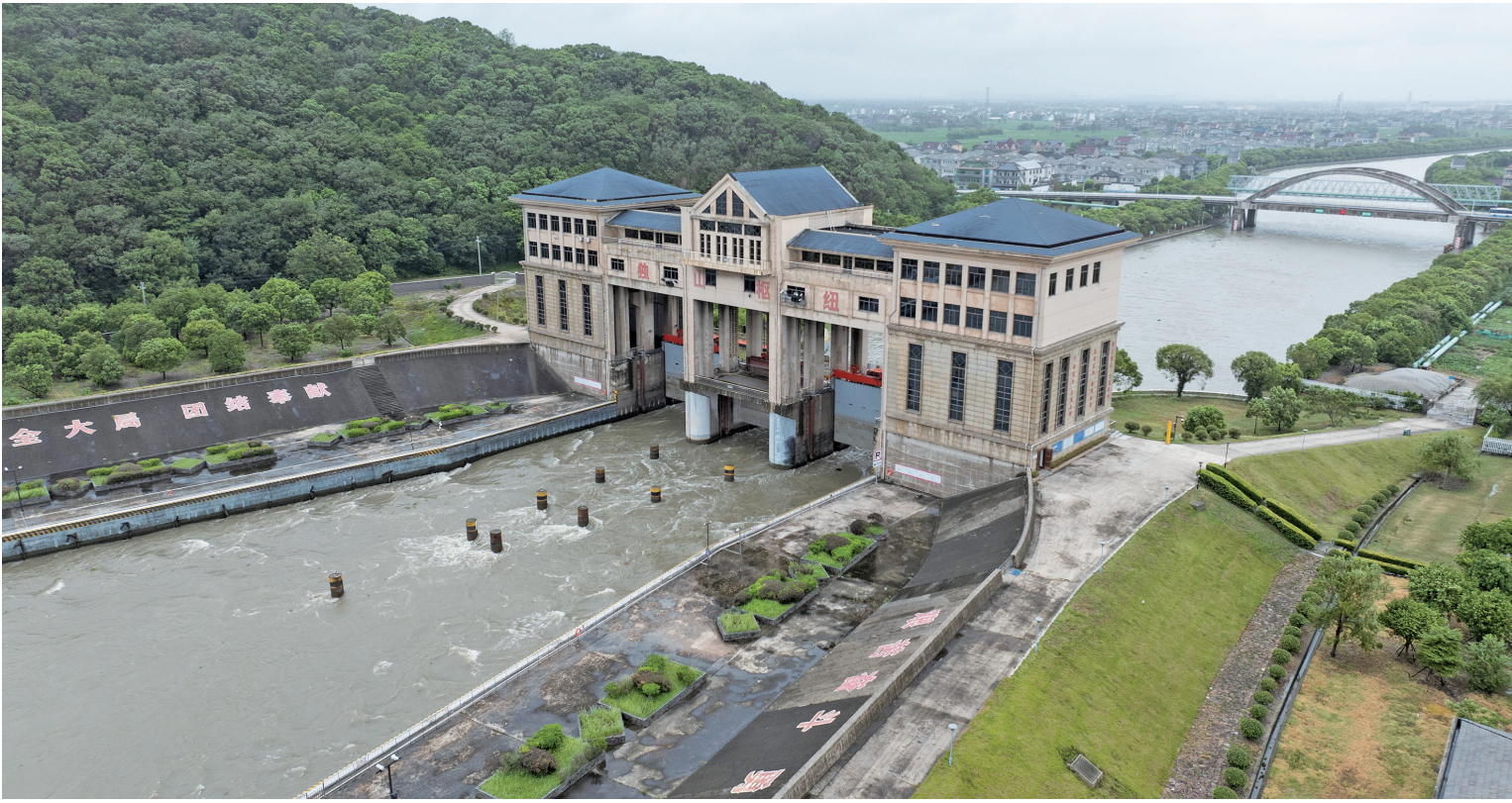
昨天，独山枢纽三孔全开运行，全力排涝。
