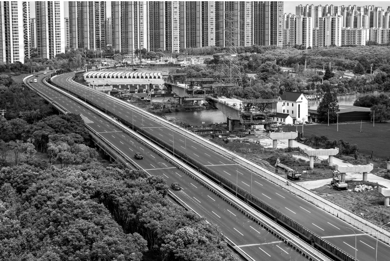
前天,在S302平湖射线二期二阶段项目施工现场,工人们正在进行改路封道作业。据了解,该项目采用“高架+地面道路”形式,主线双向六车道,设计时速80公里,建成后将畅通区域交通动脉。
