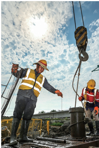
嘉兴南站进出站通道工程施工现场，一线建设者顶着烈日，挥汗如雨，全力推进桩基施工，确保项目建设步履不停。
