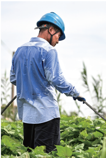
嘉兴市区湘家荡大道，电力工人在高温中施工。
