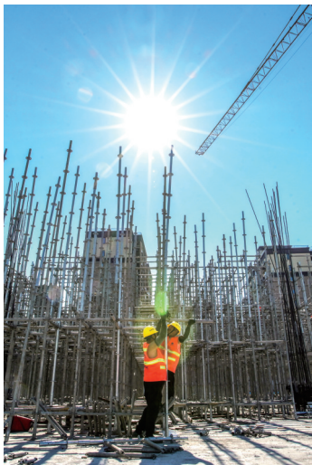
嘉兴市南湖区新丰镇交通枢纽项目现场，建设者在烈日下挥汗赶工。
