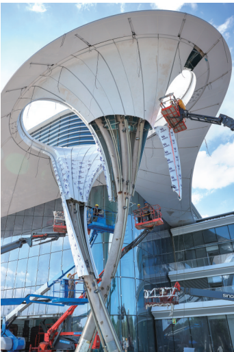
桐乡市凤凰湖畔，振石广场综合体建设初具规模，建筑工人抢抓施工节点有序推进建设。
