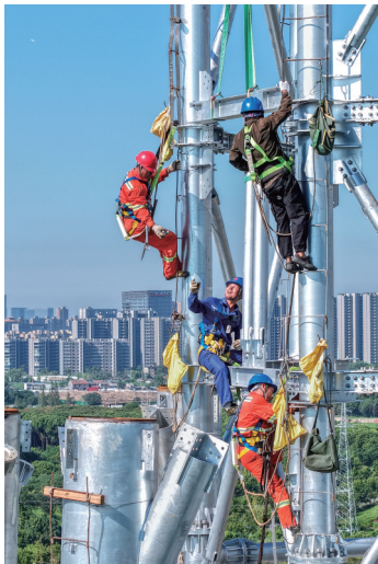
嘉兴市广播电视发射塔迁建项目建设正酣，建设者在酷暑中全力推进工程进度。这座被称为“禾兴塔”的城市新地标已悄然突破60米高度。
