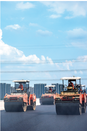
秀洲区王江泾至新塍公路工程(524国道二期工程)二标段沈家桥互通主线桥上，工人们趁高温晴好天气铺设沥青。
