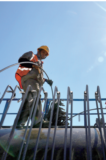
嘉兴至枫南市域铁路土建施工SG2标项目现场，中铁一局集团有限公司的施工人员进行右线7-8跨现浇梁底板钢筋绑扎作业。
