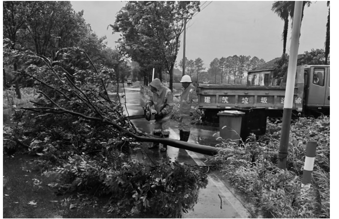
一线巡视 保障安全 昨天,秀洲区洪合镇城建办对辖区在建工地、农民自建房、交通市政基础设施开展安全巡视,及时处理安全隐患。 ■通讯员 苏雪怡 摄影 记者 王 蓉
